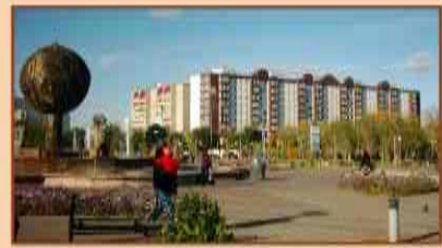
Новый университет (Архитекторы: М.А. Салиев, И.А. Салиев). Фото 2007 г. Neuer Universitäts + Tselinograd. Blick vom Hauptplatz. Foto 2007
